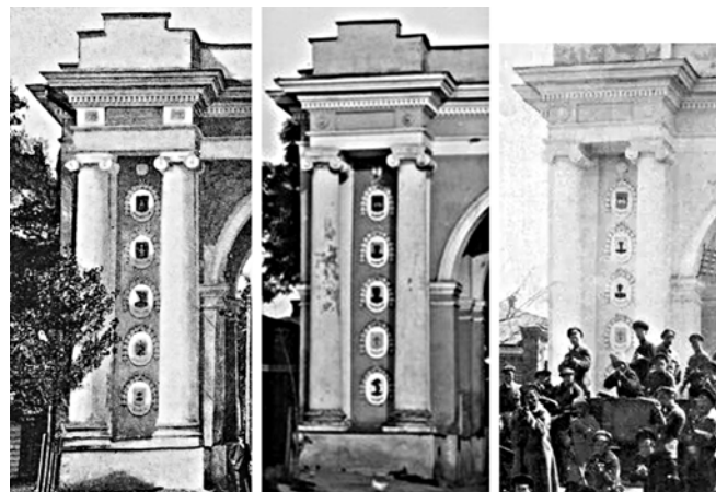
Ил. 11. Сравнение дореволюционных фотографий (с 1890-х по 1918 гг., илл. 8–10) на левом пилоне Триумфальной арки в Новгороде-Северском.
