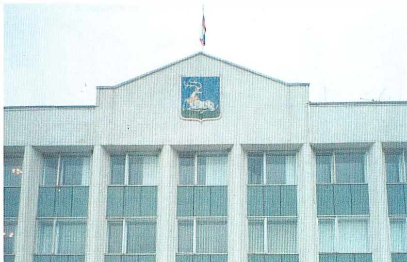
Фасад здания администрации Одинцовского района. В 1997 году надстроен фронтон специально для установки герба.
